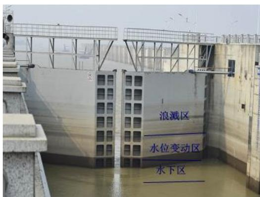
图1 钢闸门腐蚀环境示意图
