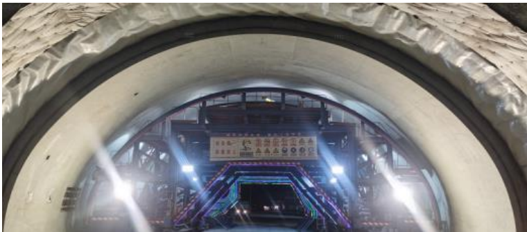
图 9 三次衬砌混凝土拆模后混凝土外观图
